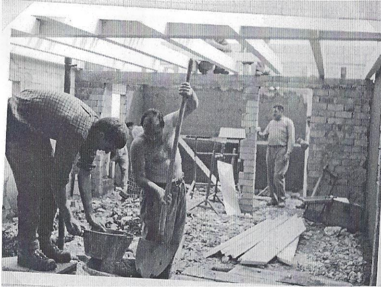
De la chambre vue en direction de la cuisine, la charpente est installée
