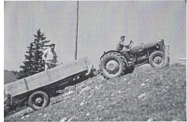
Transport de pierres pour les fondations juillet 1959
